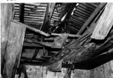
16 屋根の鉄板はモヤに直接葺かれている
