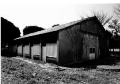
4 東側から見た全景 風除室は失われ、破風板も損傷している 木製窓は金属製パネルで覆われている
