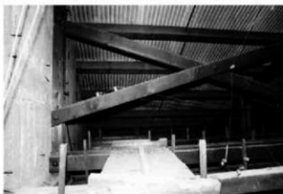
39 ト拉斯相互の桁方向の振れ止め
