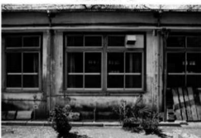
4 南東面の窓 窓枠は鉄板で覆い
