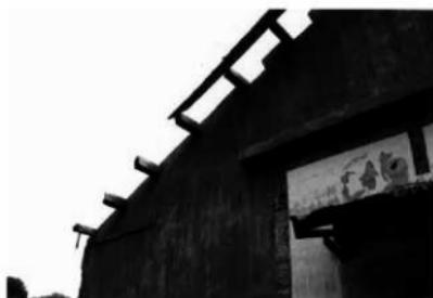
28 モヤの位置にあわせてコンクリートの壁が欠き込まれている
