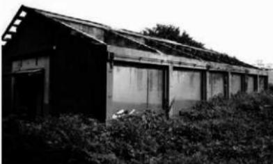
25 同左近景 モヤは切断されているが部分的に残っている
