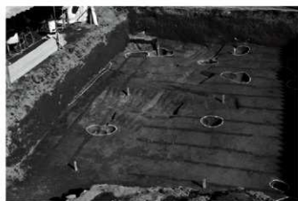
西ノ原遺跡第 148 地点全景中央
