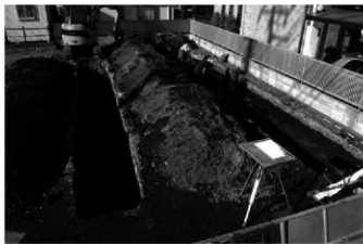
駒林遺跡第 15 地点調査風景
