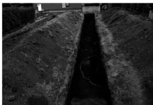
大井宿遺跡第15地点試掘調査トレンチ2
