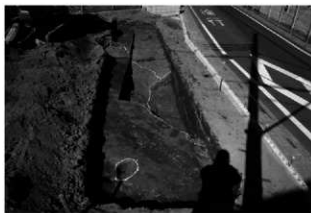
浄禪寺跡遺跡第32地点試掘調査トレンチ1
