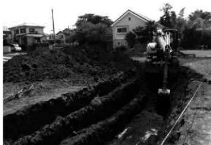
浄禪寺跡遺跡第9地点本調査表土除去風景
