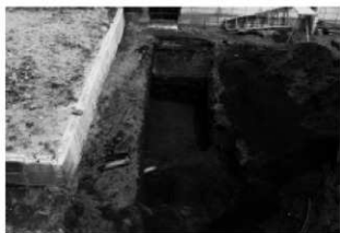
大井氏館跡遺跡第19地点トレンチ
