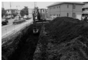
西ノ原遺跡第134地点トレンチ
