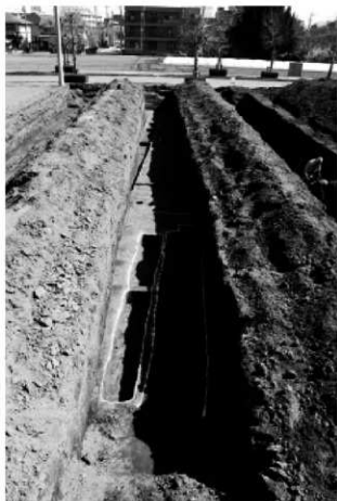
大井氏館跡遺跡第20地点トレンチ
