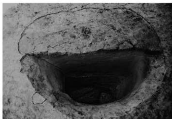
SE725 断面 (南から)
