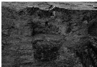
15SE162 断面下部(南東から)
