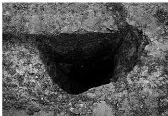
SB1100-P278 断面(北西から)
