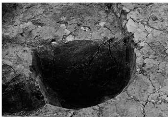
SB1014-P119 断面(南東から)
