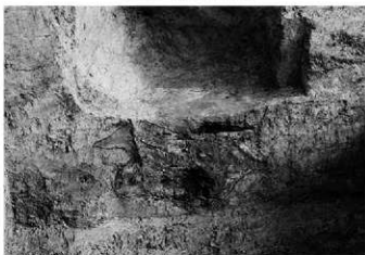
15SE471 断面下部(北西から)
