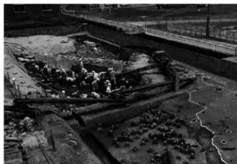
流路1 作業風景 南から
