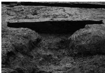
SD3 土層断面 西から
