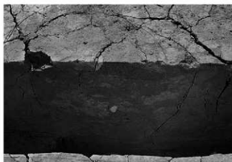
P81 セクション 東から
