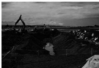
03旧河川1 作業風景 (東から)
