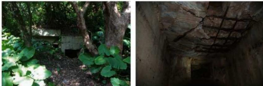
弁ヶ嶽の通信所跡（左：近景　右：内部天井の鉄筋）　鉄筋や厚いコンクリートなど、頑強な構造となっている。
