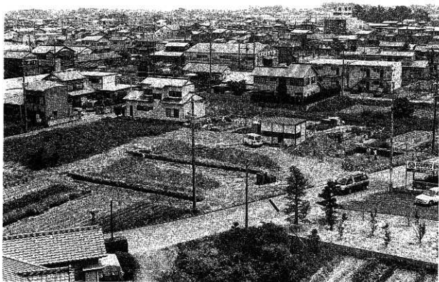
1 調査地区全景 (北西から)
