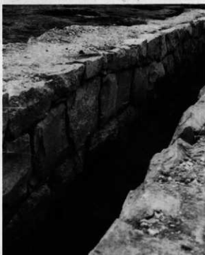
5 ▶ 暗渠側面 (東側)
