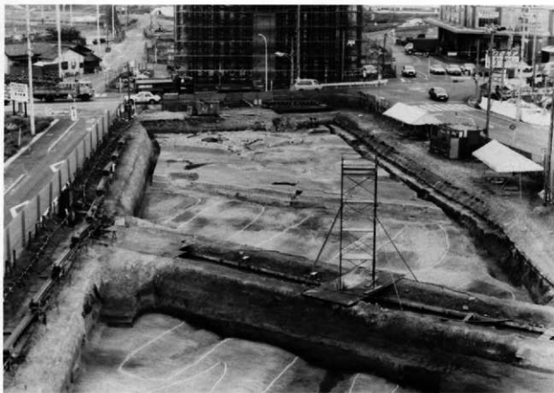
61A区 西から
