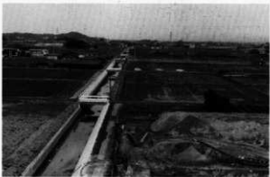
図8 岡島町4号線排水路
