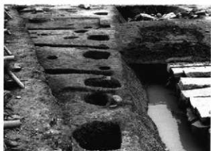
▲SA001完掘状況（西から）
