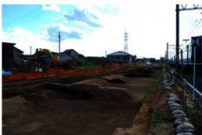
08Aa区 G層完掘削状況（北西より）
