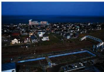
5区近景(南西から)
