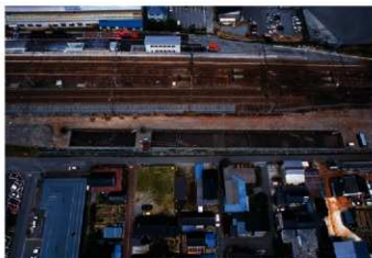
R6・7区 完掘(上空から)
