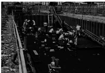
R5区 作業風景 (東から)
