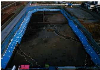
6区近景(西から)
