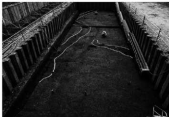
SD102・SX103 完掘 (東から)
