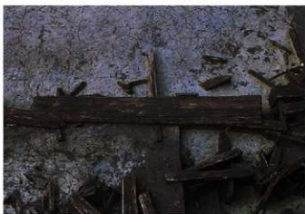
SX119 における足場板と枕木 (南から)
