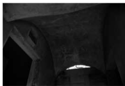
防空壕 現況 (平成 28 年 3 月時点)
