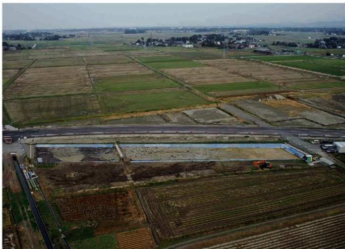
調査区全景 (上空南西から)
