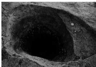
SE2147 断面(北東から)
