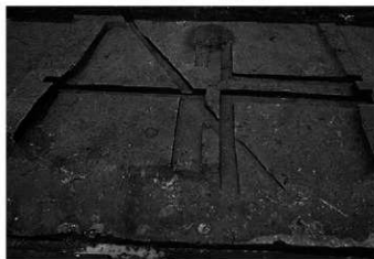
SI1630 機能面全景(南東から)
