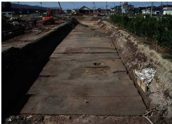
市道1区 東側部分 完整全景(東から)
