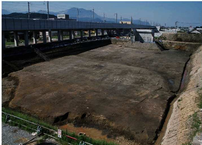
KC3区 Ⅴ層上面の地形(北東から)
