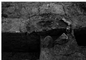
SL6014 土層断面(西から)
