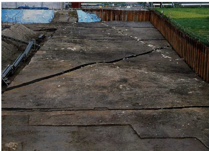
市道2区 VI層上面の地形（東から）
