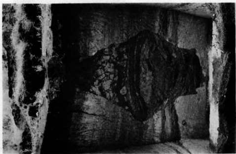
1. 隧道断面 (西から)
