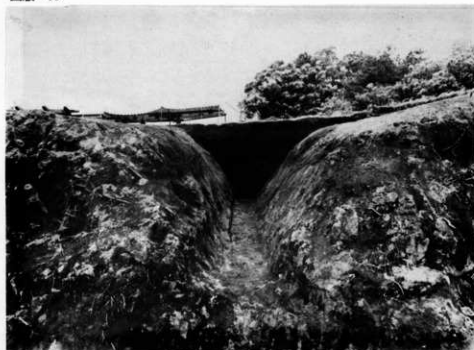
1. 空堀SD2遠景 (東から)
