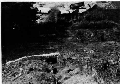
1. 南側平坦地調査前 (北から)
