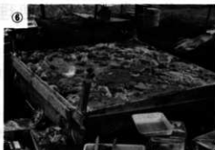
⑥ 表面に発泡ウレタン樹脂を流し込み、さらに頑丈に固定する。発泡ウレタンの節約のため、ビニール紙等で風船をつくり、つめる。発泡が始まったら板等で圧力をかけ平らにする。 薬劑：ハイブロックス（主劑・硬化劑）主劑対硬化劑＝1対1
