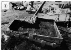
8 遺構の天地を逆にした後、裏側の土を除去する。3で差し込んでいた針金が見えたら、さらに最大限にうすくして全体重量を軽くする。
