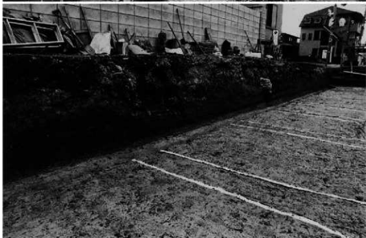
b. A区北壁土層断面 (南西から)
