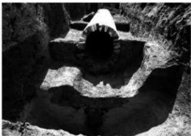
fig.102 煉瓦下水道構築状況
