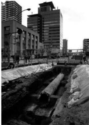
fig.103 旧居留地内煉瓦下水道出土状況（北から）
