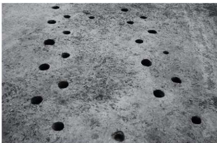
第 1 ・ 2 号 掘 立 柱 建 物 跡 完 掘 状 况
