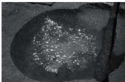
第11号粘土貼土抗 完掘状況
