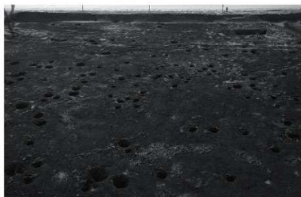
第 19 号 ビット 群 完 掘 状 況
