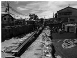
写真2 2～4区ベルトコンベア使用状況
