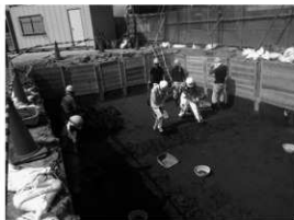
写真1 1区人力掘削風景
