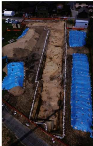
3 地点完掘状況
