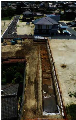
1 地点完掘状況
