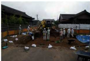
写真3 1地点機械掘削状況
