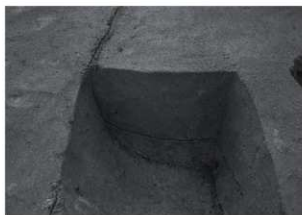
100 ST8046 断面 A1 (北東から)
