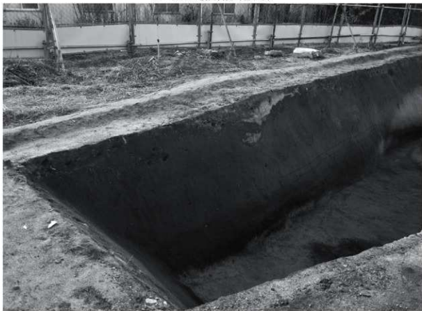
32 SX5110 断面 (北東から)
