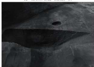
14 SD4042 断面 (北東から)
