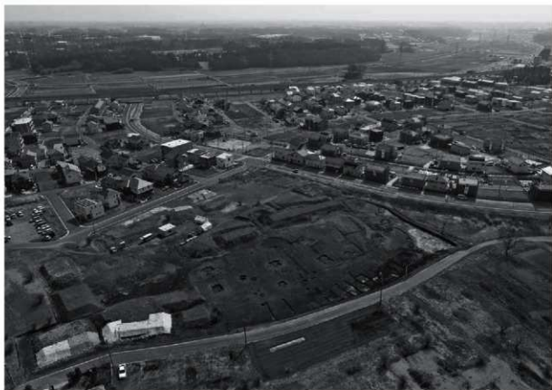
遺跡遠景（北西から）
