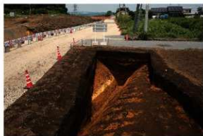
第1号堀跡完掘状況（南から）
