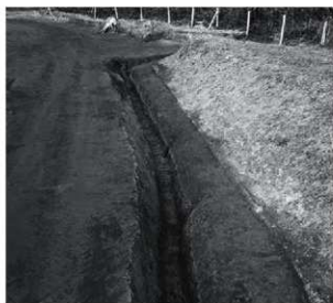
第5号溝跡完掘状况
