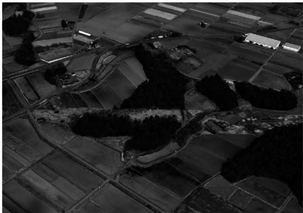
遺跡遠景 (南東上空から)
