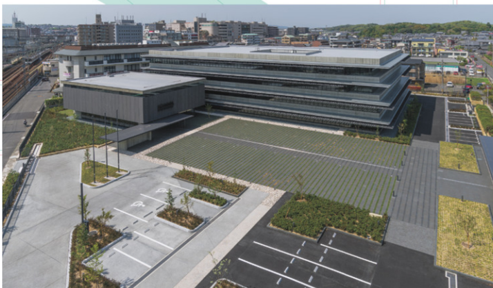
⑧ 本庁舎の敷地全景(南から)
