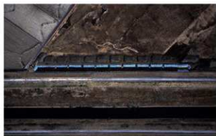
1 3区近景 (西から)
