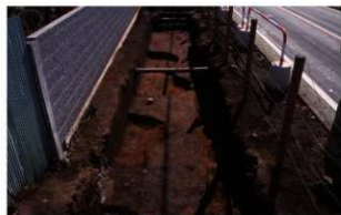
5 東2次北調査区北側(北西から)
