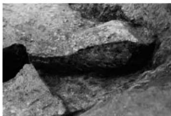
A-004 粘土溜断面状況
