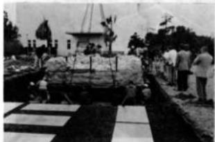
⑦ 据え付けにあたっては、運搬作業前に基礎工事を実施する。据え付にあたっては、実測図をもとに、レベル等を正確に合わせて作業を進める。
