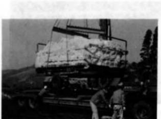
⑥ 造構の切り離す作業後、運搬はクレーン車により釣り上げ運搬車に積載し、移設先(王子跡遺資料館予定地)へ運搬する。
