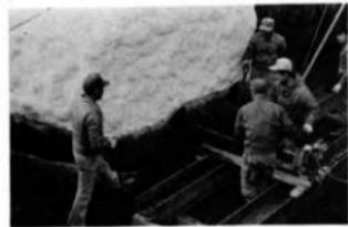
③ 分離するため、床面下位にH鋼貫入のため、水平ボーリングを実施する。
