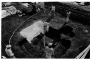
① 遺構の表面を清掃する。通常は遺構表面の土壤粒子を固定するためサンブレンを散布する。硬質発泡性ウレタン樹脂を約20cm程度吹付け作業を実施する。
