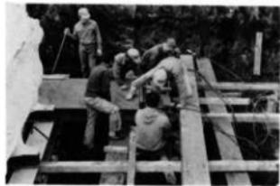
⑤ 硬質ウレタン樹脂の吹付け後、床面の切断のために鉄板挿入のために、堆進用ジャッキにより鉄板(12mm)を挿入し、切り離す作業を実施する。
