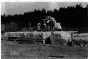
⑧ 据え付け実施後生コンクリートを流し込み、基礎工事を終了する。その後、上屋構造物の基礎工事実施し、建物の建設作業を実施する。
