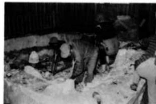
⑨ 建物建設終了後、梱包を解き、ウレタン及び鋼管を除去し、造構壁面は崩壊をしないように、化学処理で補強作業を実施する。
