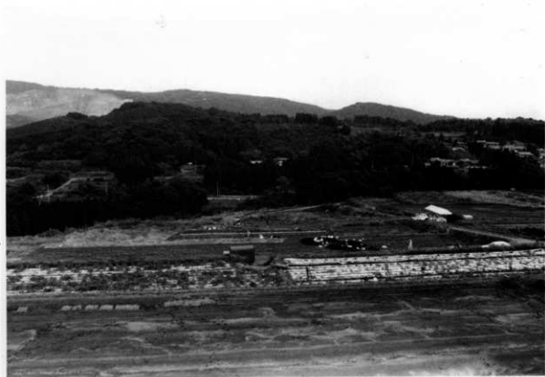
東下原遺跡全景(西から)
