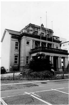
曳家工事前の旧鹿児島県庁舎本館
