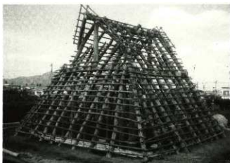
④ 小屋組(小舞取り付け)
