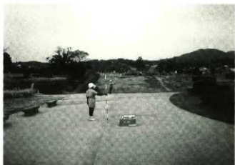
② 園路工 (完成)
