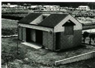
⑤ 便益施設 (完成)
