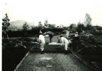
① 園路工 (火山灰による舗装)
