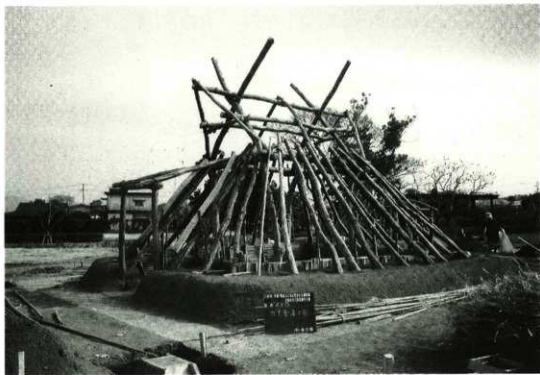
第38図 2号住居復元工事写真
