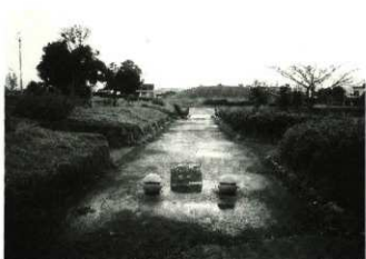
④ 車止め工 (完成)
