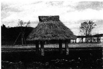
復元建物 (SB601・W→E) 復元された4本柱建物で、後方に植栽された木々、手前に万塚環状列石外帯がみえる。
