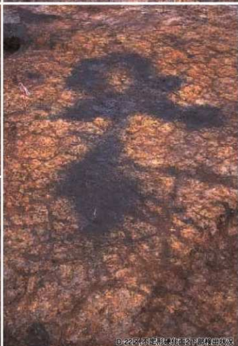
D:22区,不定形残北面2下部楼出状况
