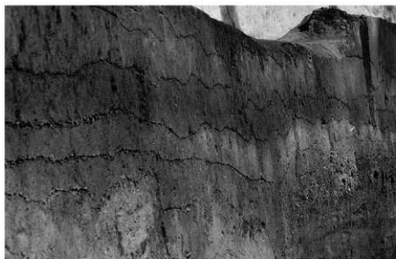
下層確認トレンチ断面①
