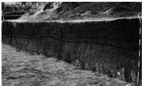
C・D-11・12区 下層確認トレンチ断面
