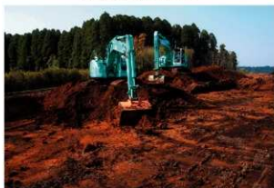
重機による表土剥ぎ
