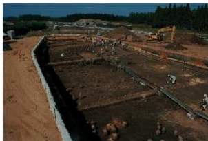
作業風景 (Ⅶ, Ⅷ層)
