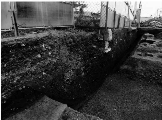
(1) 本丸の堀 (北西から)
