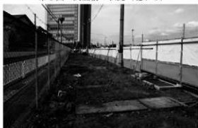
第4図 調査前の状況（南から）
